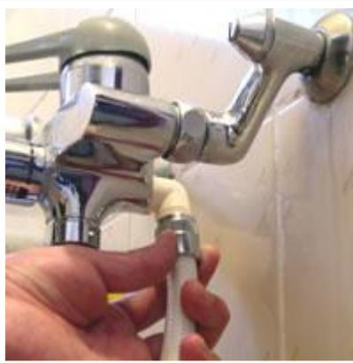
付属のホースを取り外したところに接続します。水栓側ホースネジの規格は標準的な呼び 13 の 1/2 です。ので、お使いのシャワーホースによっては変換アダプターが必要になる場合がありますが、変換アダプターも付属していますのでほとんどのものに接続可能です。
